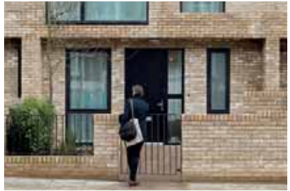
Indgange til boliger, Schaerbeek, Navez / V+
