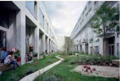
Kantzone - terrasse langs facade til boliger, BIGyard Berlin, Zanderorth Architekten
