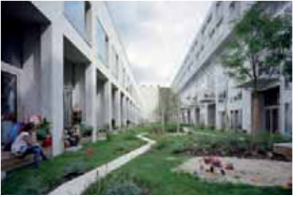
Tilbagetrukne stueetager, BIGyard Berlin, Zanderorth Architekten
